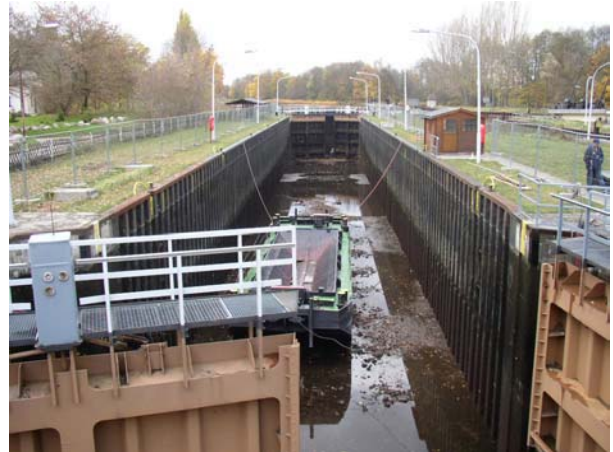
15.11.2004 – Schleuse Bischofswerder Reinigung bei einer Bauwerksinspektion
