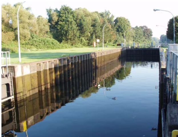
29.08.05 – Ansicht Schleuse Liebenwalde
