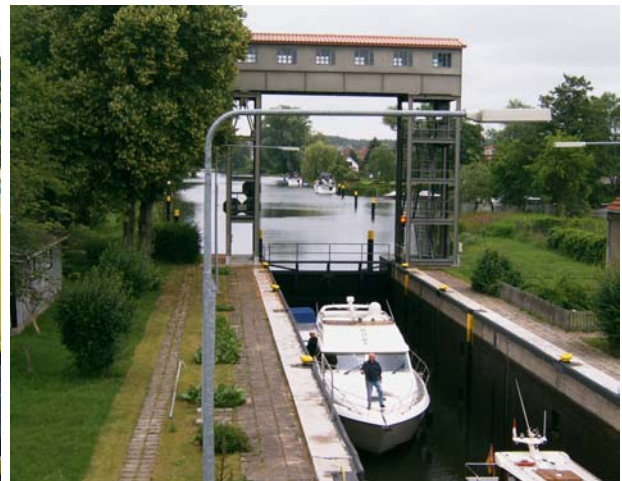
02.08.05 – Ansicht Schleuse Bredereiche, außergewöhnlich ist das Hubtor am Oberhaupt
