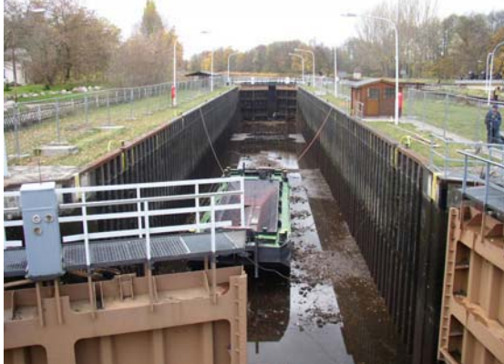
10.11.04 – Blick in die trockengelegte Kammer der Schleuse Bischofswerder, OHW km 4,53
