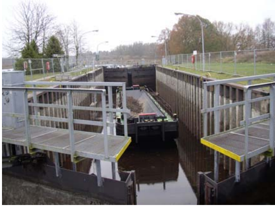
03.11.04 – Blick in die trockengelegte Kammer der Schleuse Liebenwalde, MzK km 45,30
