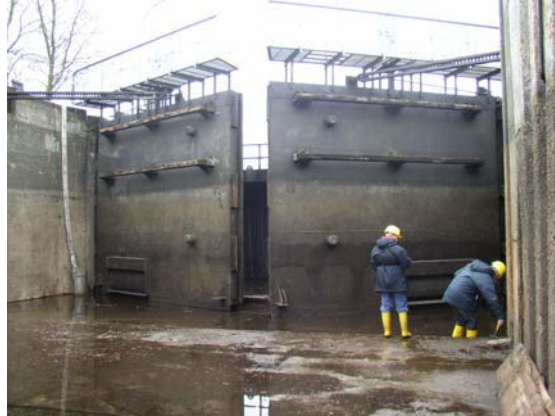
05.11.04 - Ansicht vom Untertor der Schleuse Liebenwalde, MzK km 45,30
