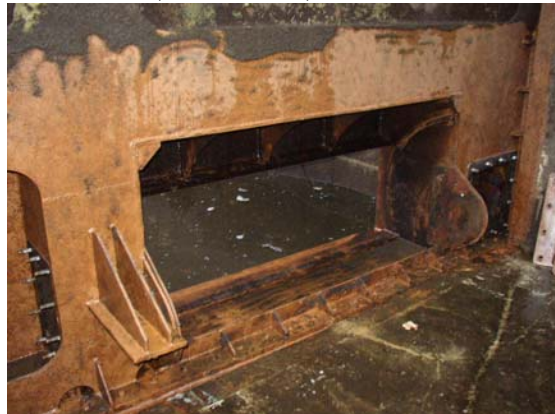
10.11.04 – Torsegmentschutz zum Füllen bzw. Entleeren der Schleuse Bischofswerder, OHW km 4,53
