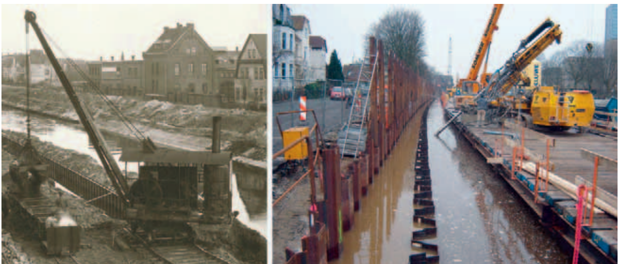
Abb. 5: Baumaßnahmen in der Stadtstrecke Oldenburg um 1925 (links) und 2005 (rechts)
