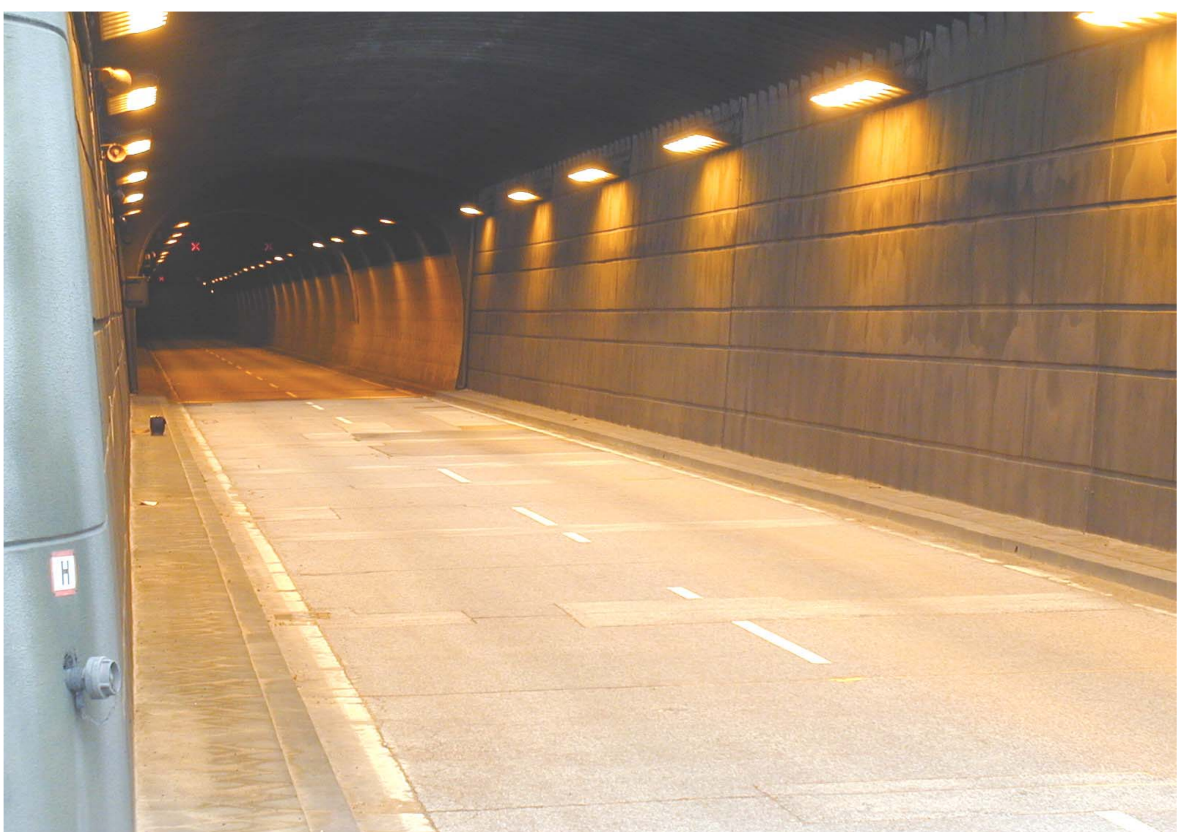
Blick in eine Tunnelröhre
