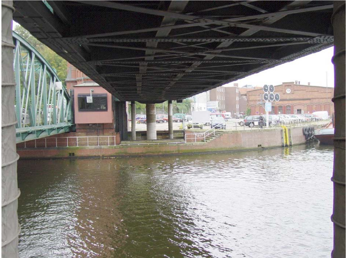
Unteransicht der Eisenbahnhubbrücke mit Hubzylinder und Stützspindeln
