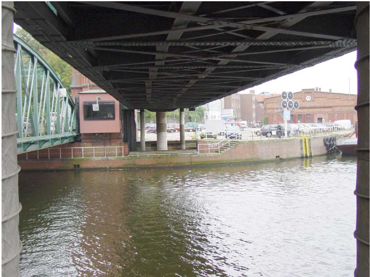
Unteransicht der Eisenbahnhubbrücke mit Hubzylinder und Stützspindeln
