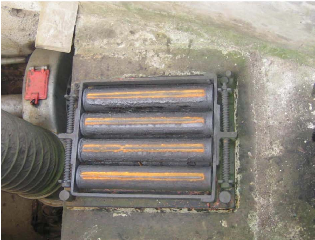
oben: festes Brückenlager unten: bewegliches Bückenlager
