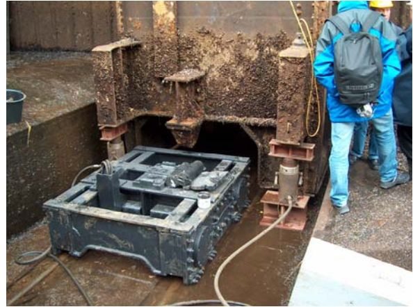
Abb. 13: Instandgesetzter Torunterwagen
