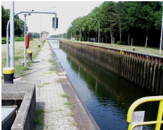
Abb. 6: Neue Schleuse Varloh
