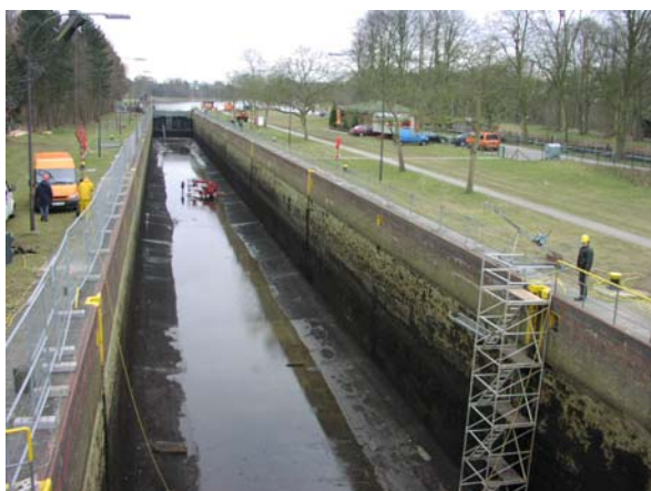
Abb. 15: Schleuse Hüntel, trockengelegt
