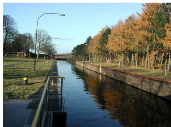
Abb. 16: Schleuse Hüntel, Blick nach Unterwasser
