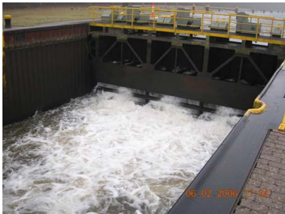
Abb. 10: Füllvorgang bei der neuen Schleuse Varloh
