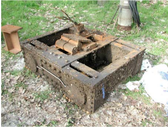
Abb. 12: Ausgebauter Torunterwagen
