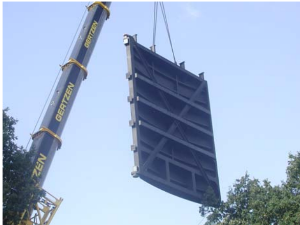
Abb. 8: Einbau eines neuen Untertores
