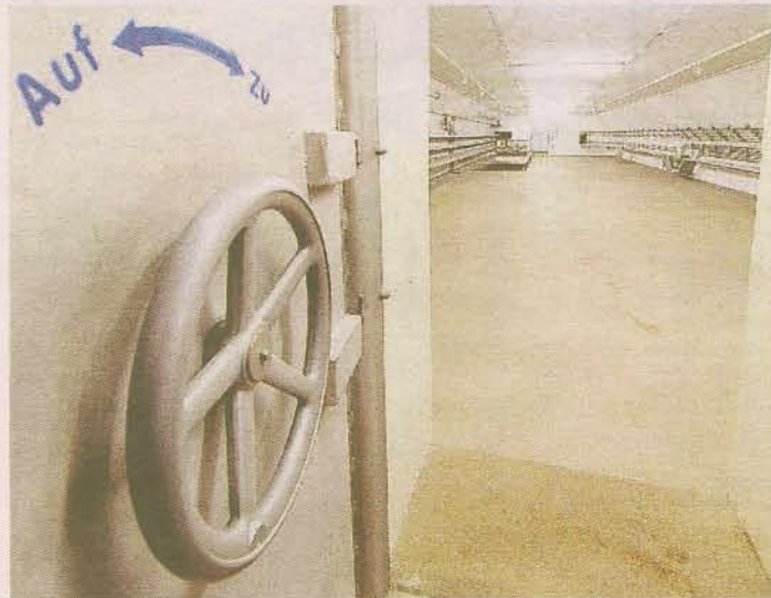
Nur ein dumpfes Rauschen erinnert im Wehr daran, dass hinter dem meterdicken Beton die Weser fließt. Fotos [2]: PDNW
