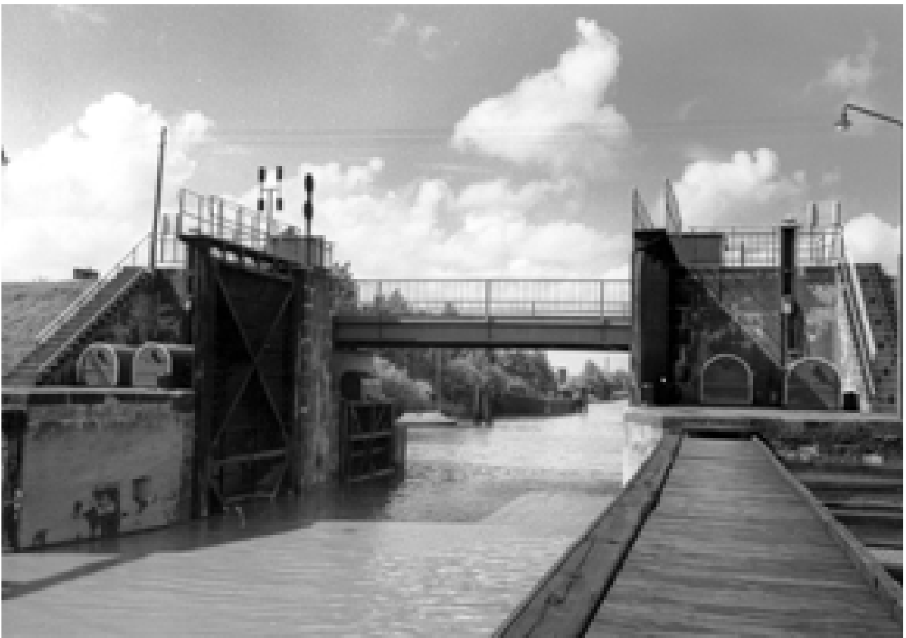
Abb. 2 Blick von der Schleusenammer auf das alte Binnenhaupt der Oldersumer Schleuse
