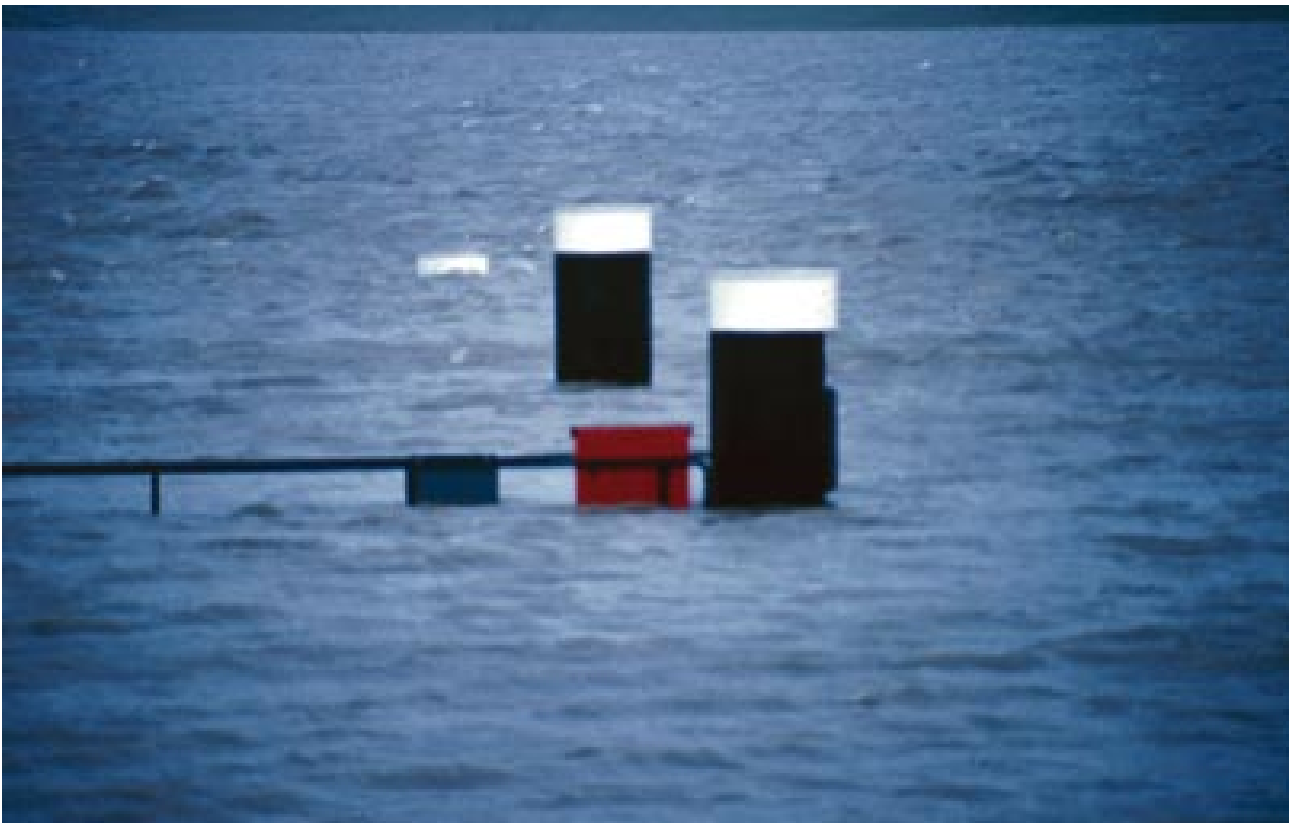
Abb. 13 Sturmflutwasserstand im Vorhafen der Schleuse im Frühjahr 1990 mit 8,40m PN= +3,40m NN
