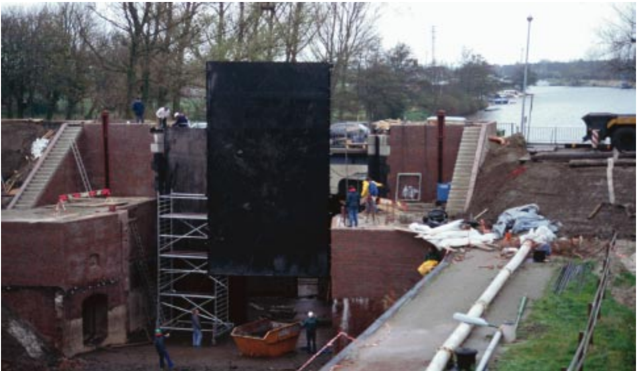
Abb. 8 Einbau der neuen Fluttore am Binnenhaupt
