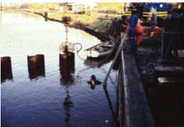
Abb. 18 Abtrennen der Baugrubenspundwände durch Tauchereinsatz
