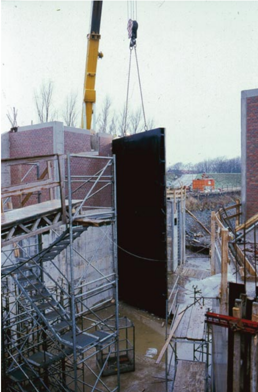
Abb. 16 Einbau des Fluttorepaares am fertiggestellten neuen Aussenhaupt
