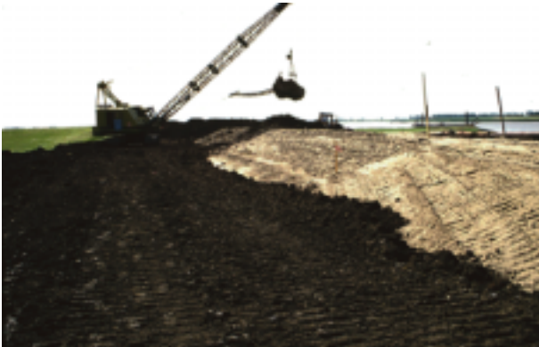
Abb. 23 Profilierter Sandkern mit Kleiabdeckung
