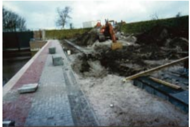
Abb. 19 Instandsetzung der Schleusenammer
