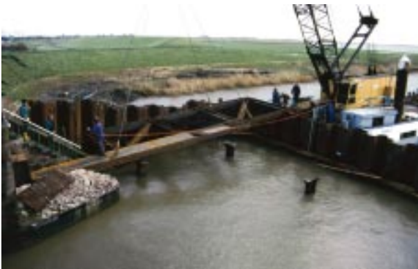
Abb. 4 Abstützung der Hochwasserschutzwand durch den Fachwerkträger
