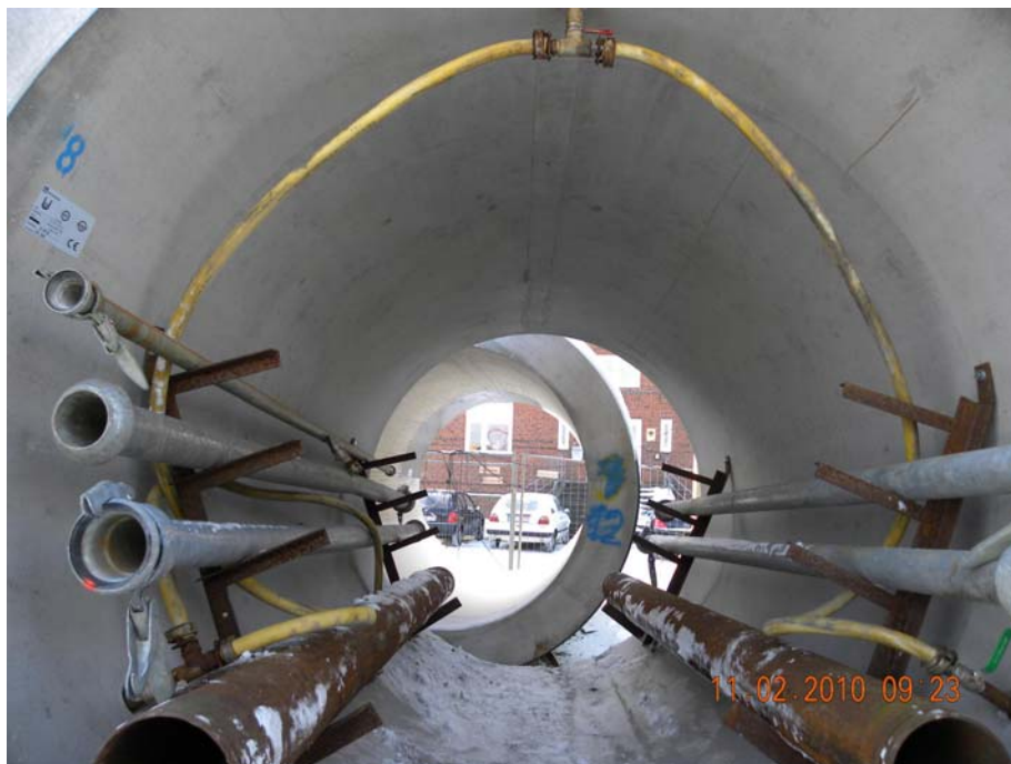
Abb. 4: Ausrüsten der Vortriebsrohre mit den Versorgungsleitungen
