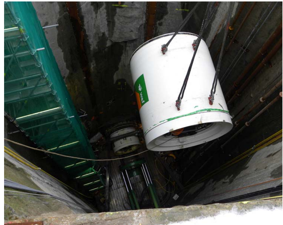
Abb. 2: Einsetzen des Maschinenrohres
