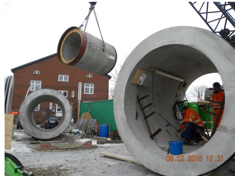
Abb. 4: Ausrüsten der Vortriebsrohre mit den Versorgungsleitungen
