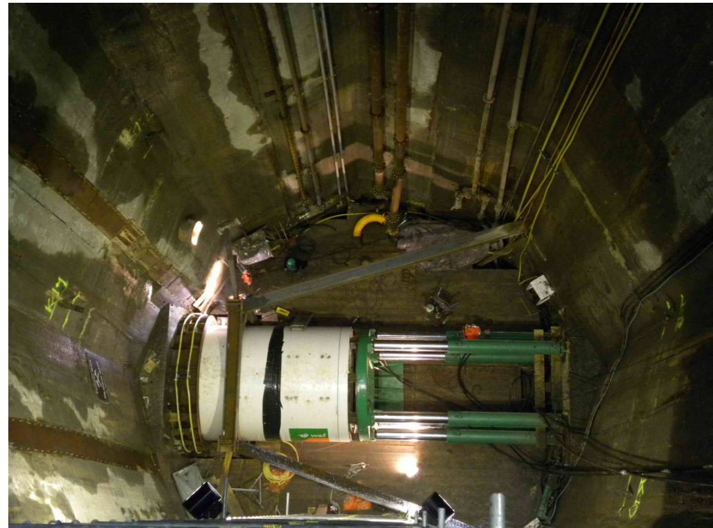
Abb.2: Blick in den Startschacht auf die Vortriebsmaschine und die Pressen
