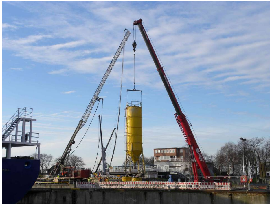
Abb. 5: Arbeiten auf der Mittelmauer
