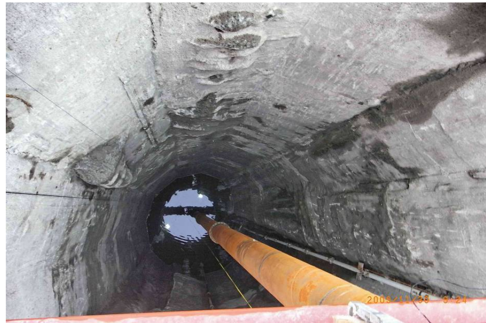
Abb. 8: Blick in den Schacht; der Lenzvorgang ist fast abgeschlossen
