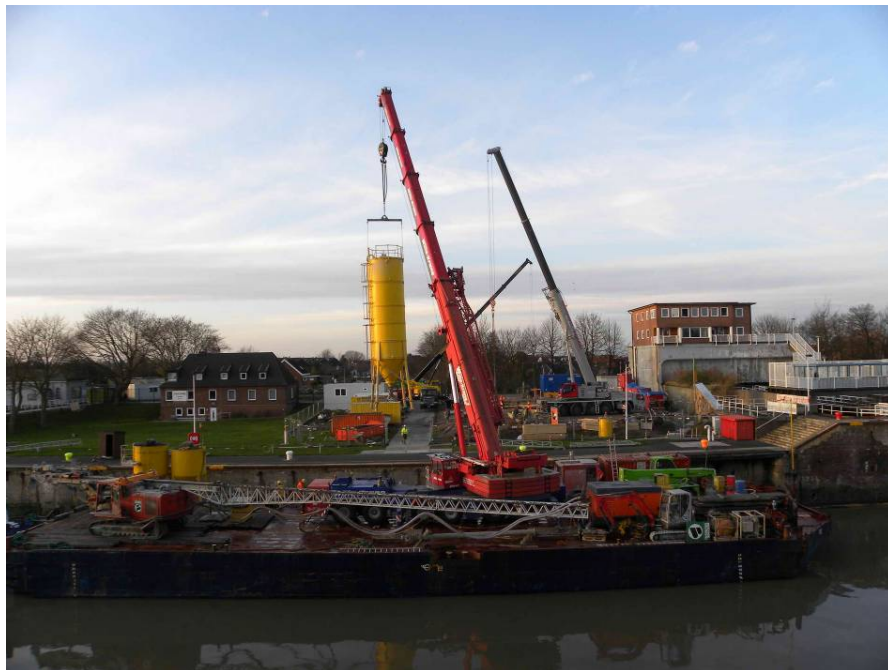
Abb. 7: Baustelleneinrichtung für die Herstellung des HDI-Einfahrtsblockes
