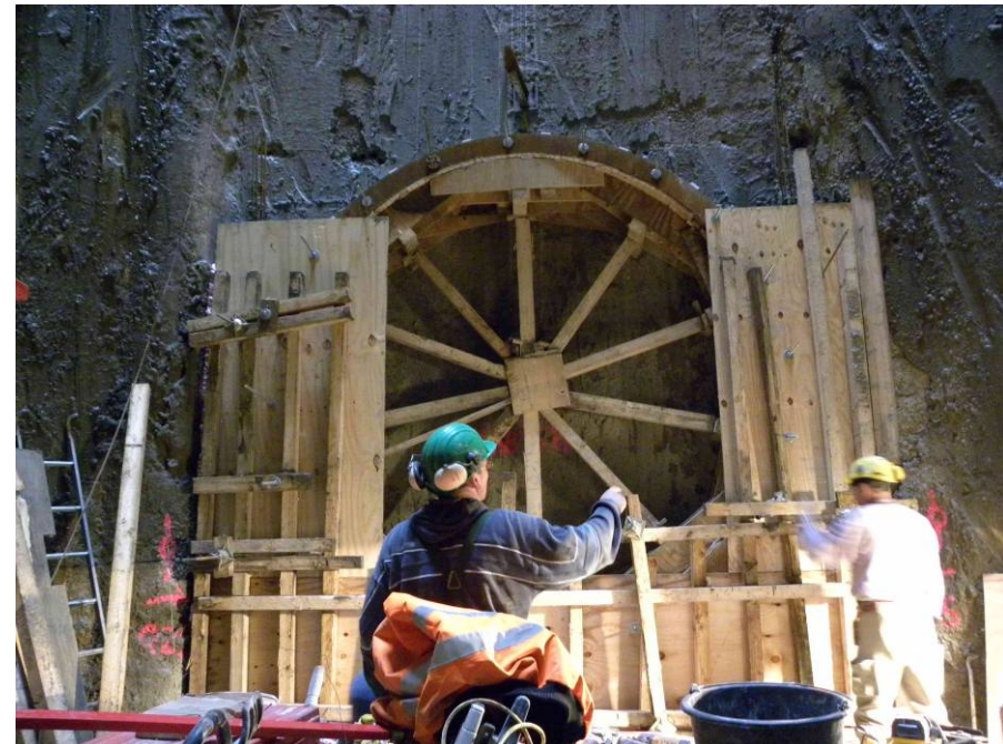
Abb. 4: Vorbereitung für die Betonage des Einfahrtsbrille
