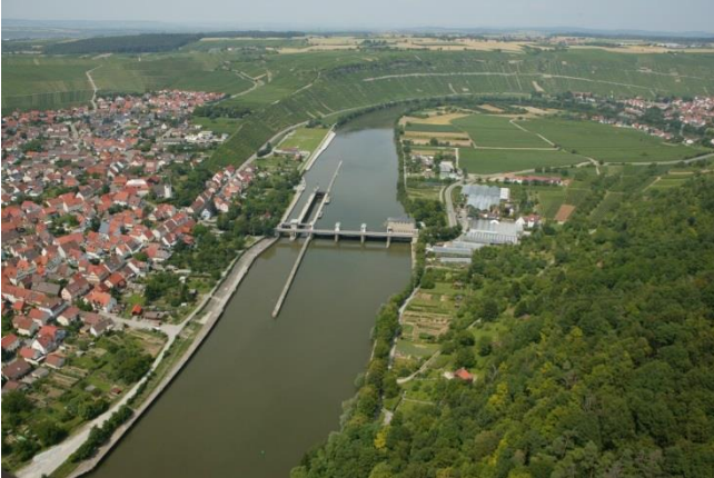
Staufstufe Hessigheim aus der Luft, © wsv.de
