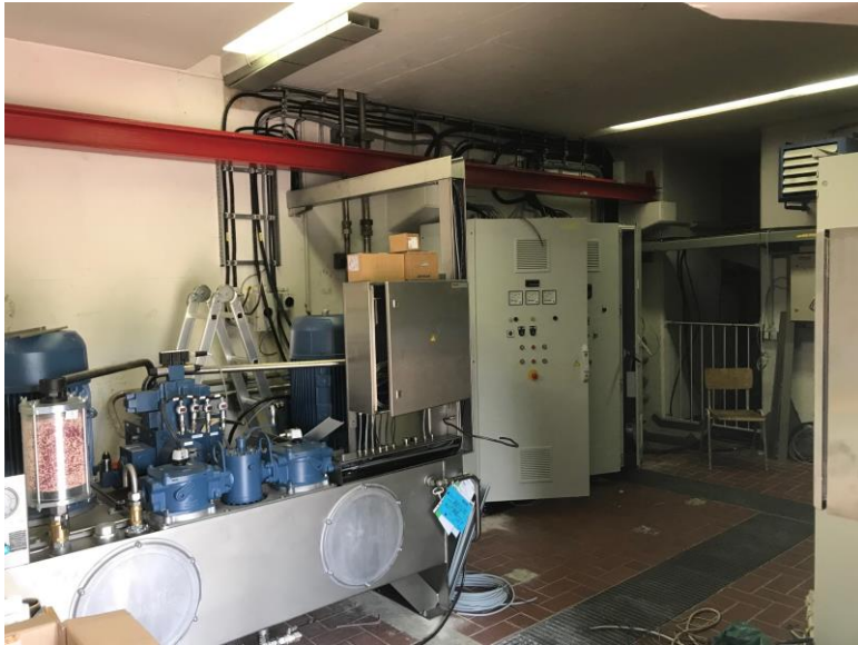
Abb.1: Neues Hydraulikaggregat für ein Untertor bei elektrischen Anschlussarbeiten
