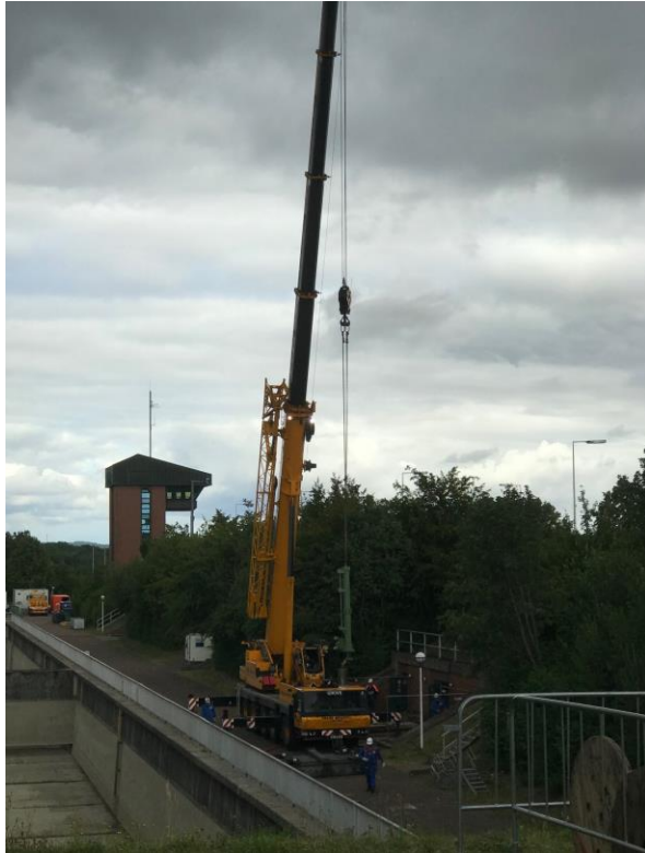
Abb.3: Ausbau der alten Verschlussantriebe
