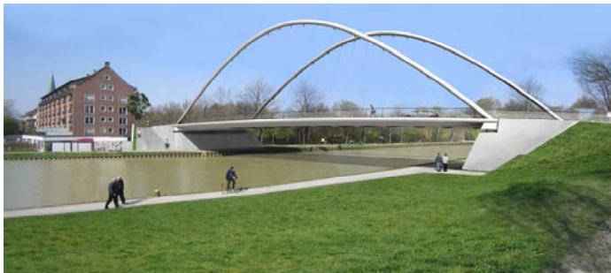
Ansicht vom Betriebsweg
