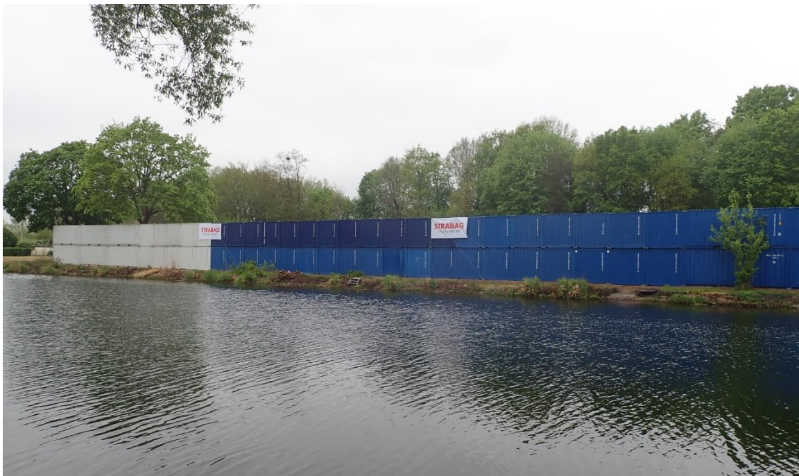
Zweilagige Containerschutzwand an der HOW
