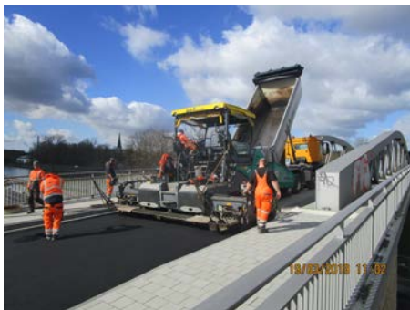
Bild 1 Asphaltierung der Rampe
