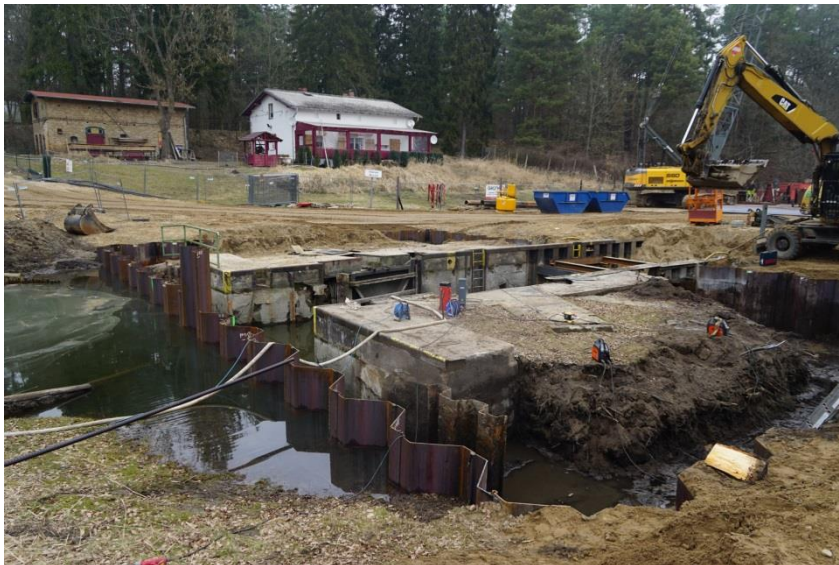
Fertiggestellter Spundwandkasten für den Abbruch des Oberhauptes Schleuse Zaaren
