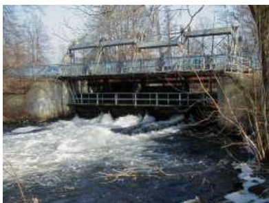
Ansicht von Unterwasser auf Großes Wehr Sachsenhausen
