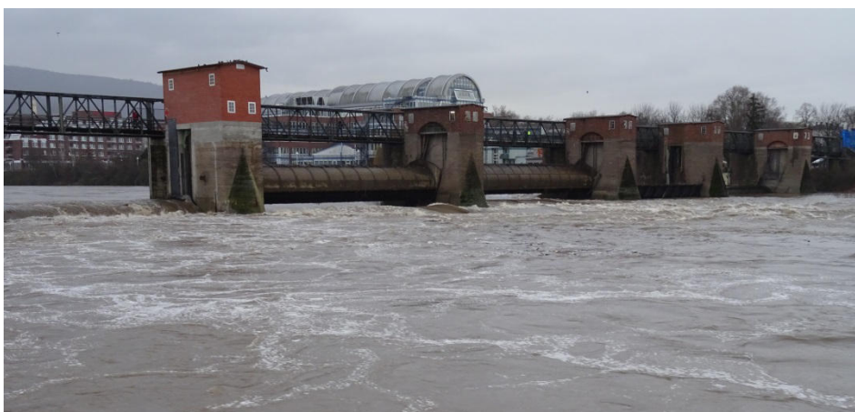
Stauaufhebung an zwei Wehrwalzen des Wehres Wieblingen
