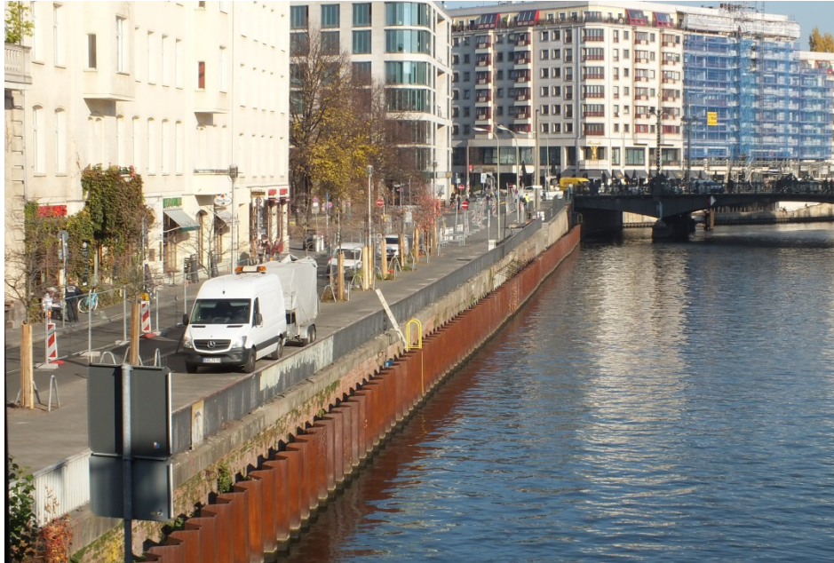
temporäre Sicherungsspundwand vor dem Schiffbauer Damm, Blickrichtung Weidendammer Brücke Arbeiten zur landseitigen Baustelleneinrichtung am 07.11.2018
