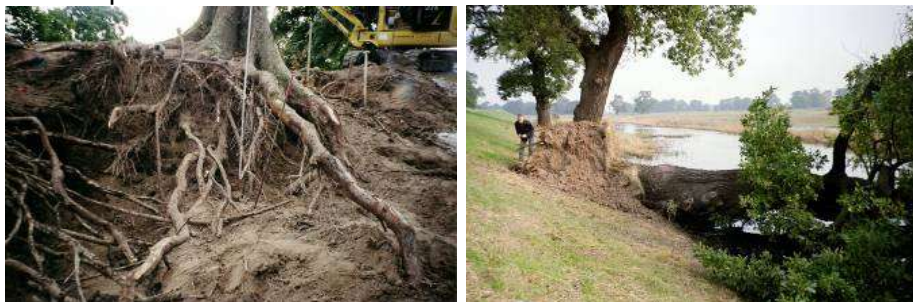
Bilder: Freigelegte Wurzeln an einem Elbedeich und umgestürzte Eiche nach Hochwasserrückgang
