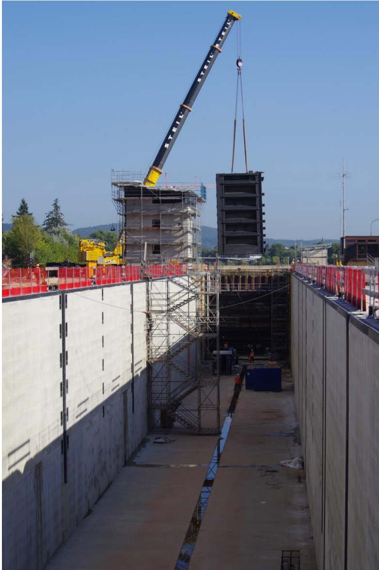
Einbau des ersten Torflügels
