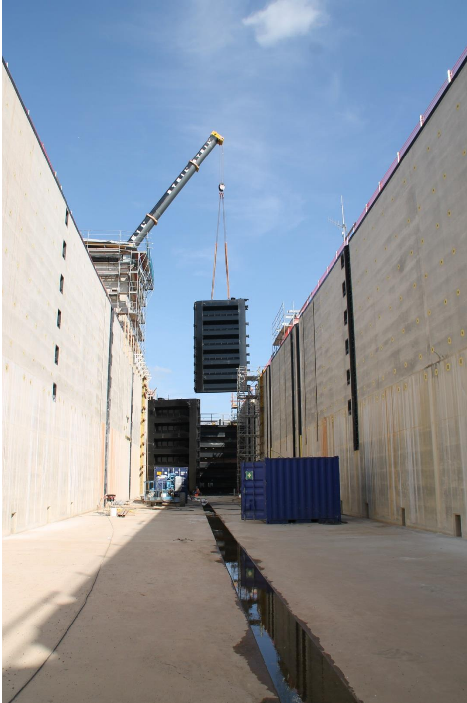
Einbau des zweiten Torflügels
