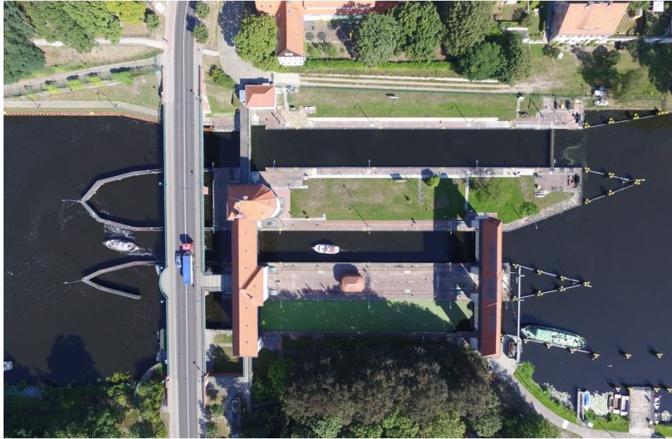
Schleusenanlage Kleinmachnow von oben
