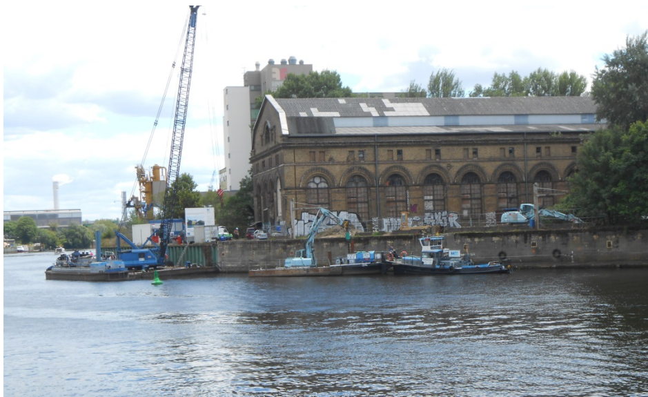
Ansicht der zu sichernden Ufermauer an der „Alten Geschützgießerei Spandau“ vor Baubeginn
