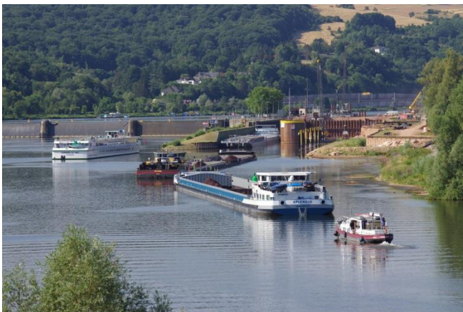
Abb.: Verkehrsaufkommen Schleuse Trier
