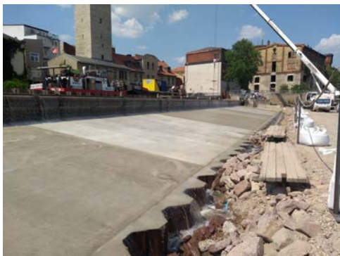
Bauausführung im 1. Bauabschnitt fertig gestellt
