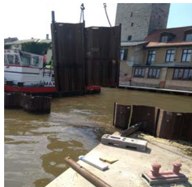
Rückbau der Spundwand im Oberwasser des 1. Bauabschnitts
