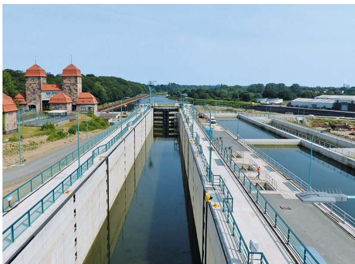
Bild: Neue Weserschleuse Minden
