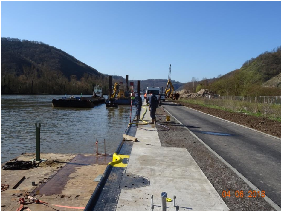
Baustelle oberer Vorhafen
