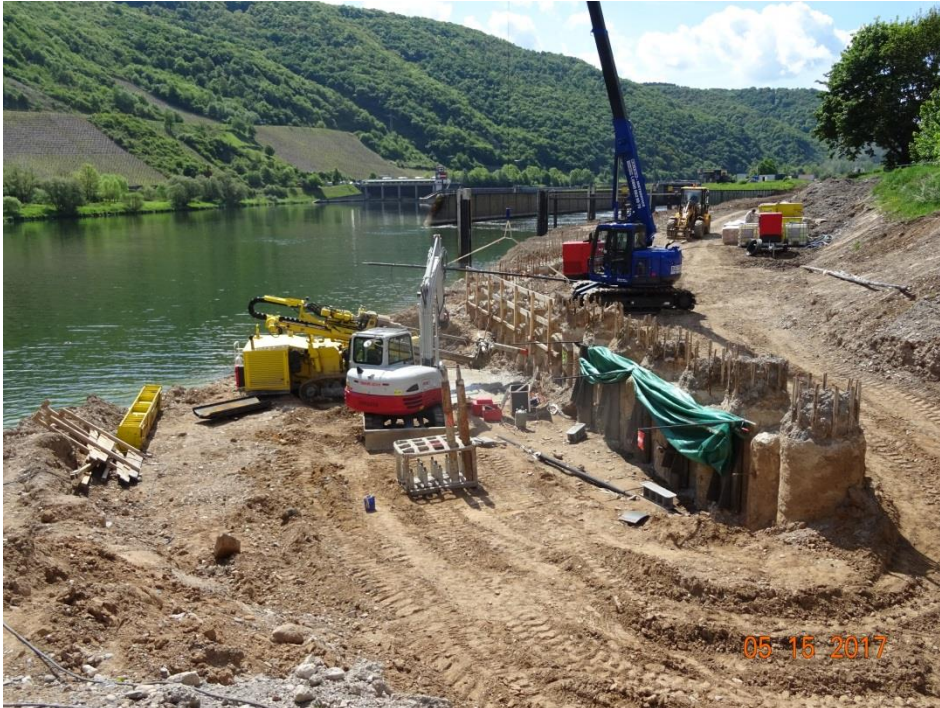
Baustelle unterer Vorhafen
