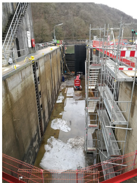
Fotos: Arbeiten an der Schleuse Cramberg
