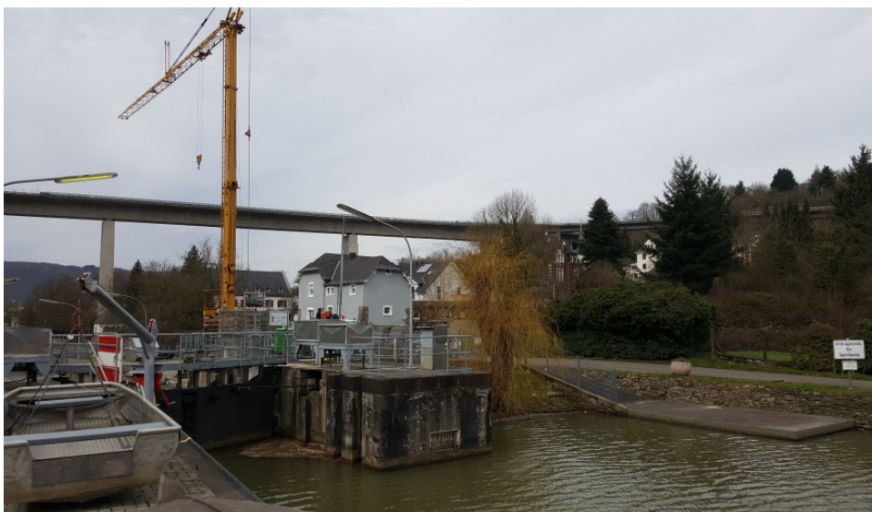
Foto: Ansicht der Schleuse Lahnstein von Oberwasser
