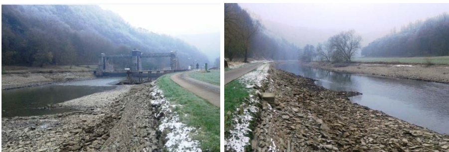
Fotos: abgesenkte Lahn im Oberwasser der Staustufe Scheidt
