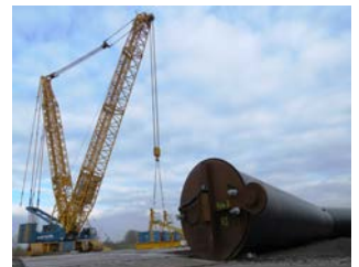
Der erste Raupenkran ist montiert
