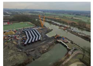
Übersicht über die Baustelle aus der Luft
