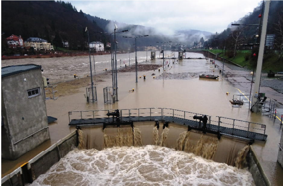
Überflutete Schleusenanlage Heidelberg
