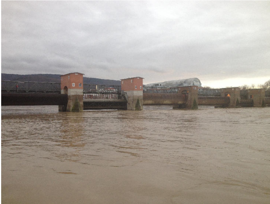
Wehr Wieblingen mit 6 gehobenen Wehrverschlüssen
