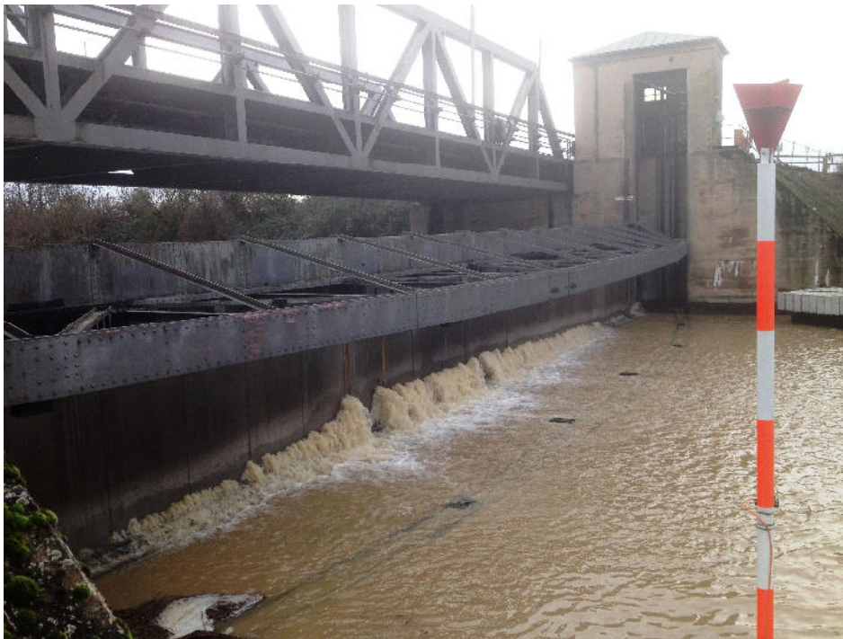
Hochwassersperrtor in Ladenburg in geschlossenem Zustand
