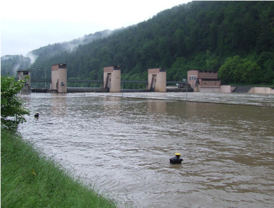
Wehr Guttenbach bei einem Neckarabfluss von rd. 1200 m 3 /s
