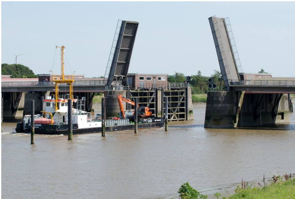
Oste-Sperrwerk mit dem Schwimmgreifer „Mittelgrund“ des WSA Cuxhaven (Archivbild)
