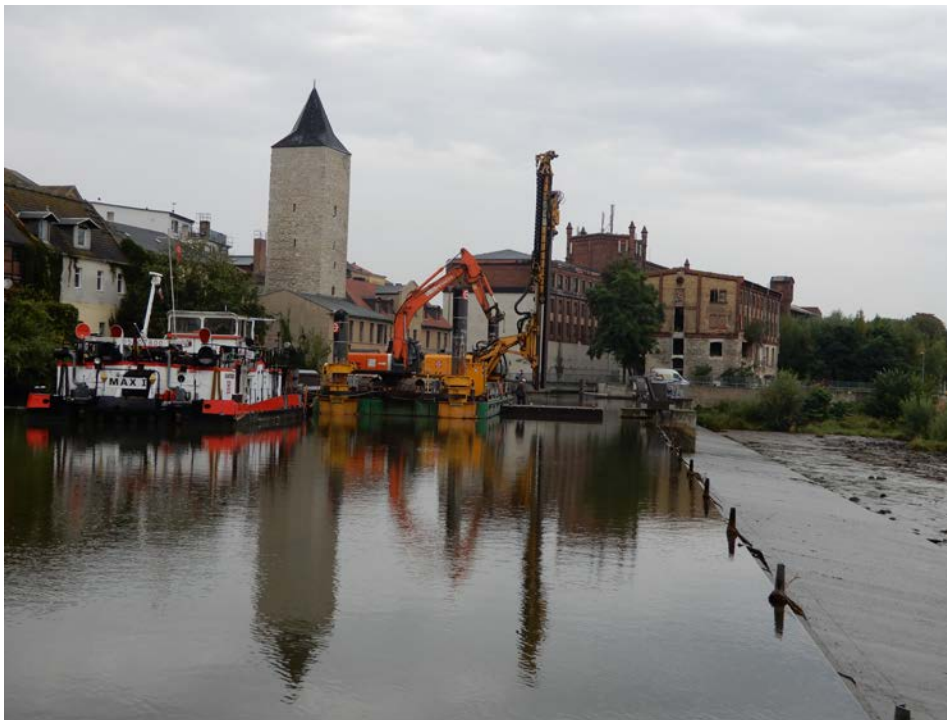
Spundwandarbeiten vom Ponton im Oberwasser des Wehres
