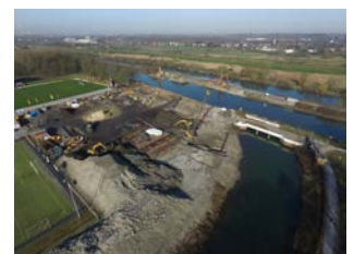
Übersicht über die Baustelle aus der Luft
