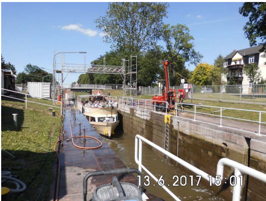
Bohrarbeiten der Schleusenkammerwände von der Planie aus bei Aufrechter- haltung der Schleusennutzung
