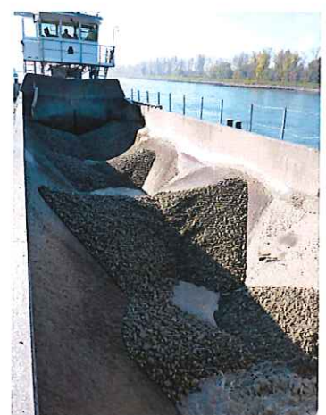
Einbau mittels Hydro- klappschute
