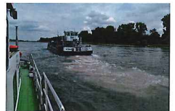
Einbau mittels Hydro- klappschute
