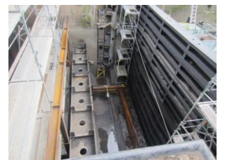
Blick in die Baugrube mit Verschubbahn
