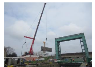
Aushub mit 400 t - Kran
