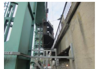
Aushub der Torteile zwischen Portal und Brücke
