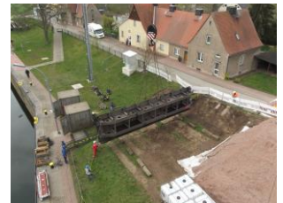
Zwischenablage bei Aushub Torteil
