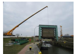
Setzen der Revisionsverschlüsse mit Mobilkran
