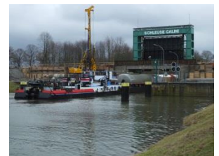
Schleuse Calbe vom Unterwasser mit Brückenbaustelle im Vordergrund
