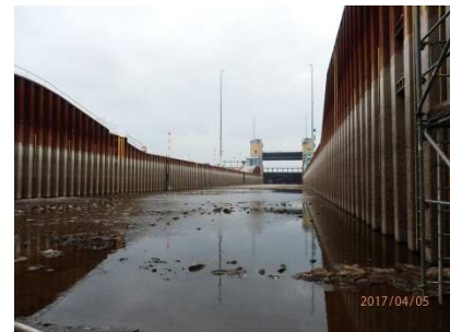
Blick in die gelenzte Schleusenkammer
