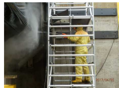
Reinigungsarbeiten am Schleusentor
