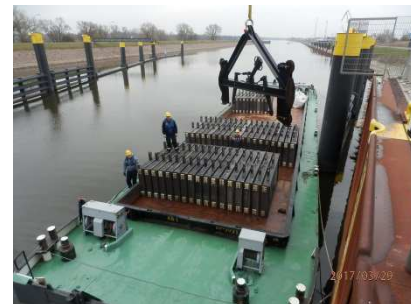
Anlieferung der Dammtafeln mit Transportschute
