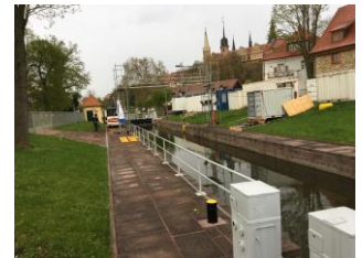
Baustelleneinrichtung und Beginn der Bohrarbeiten
