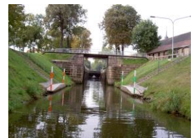
Ansicht Schleuse Meuschau vom Unterwasser
