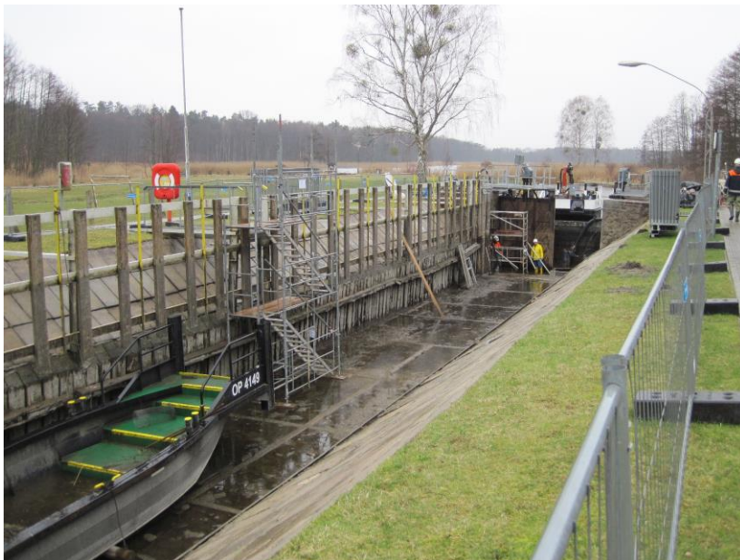
Ansicht der trockengelegten Kammer
