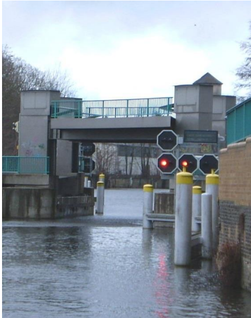
Hubbrücke Eisenspalterei beim Familiengarten Eberswalde
