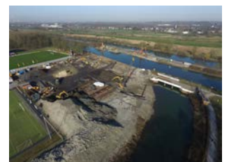
Übersicht über die Baustelle aus der Luft
