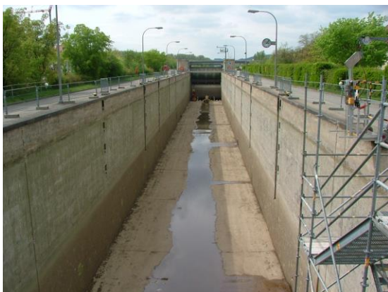
Schleuse Regensburg 2011 trocken gelegt
