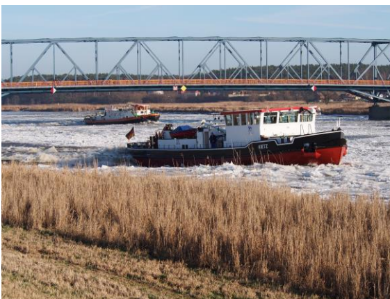
Eisaufbruch im Bereich der Straßenbrücke Schwedt am 09.01.2016
