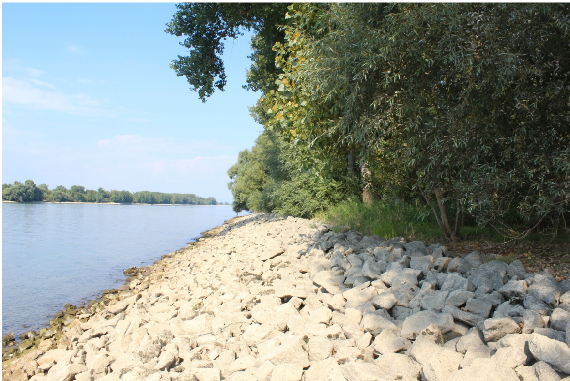
Bild: Rheinufer mit Steinschüttung in seiner heutigen Form (Foto: RP Darmstadt).
